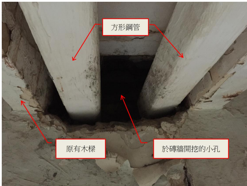
圖 5c: 在北面牆已挖掘的小孔 (事件發生後攝)
